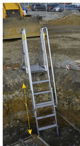
Piètements télescopiques réglables sur 4 hauteurs.
