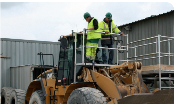
Echafaudages pour intervention sur engins de carrière
